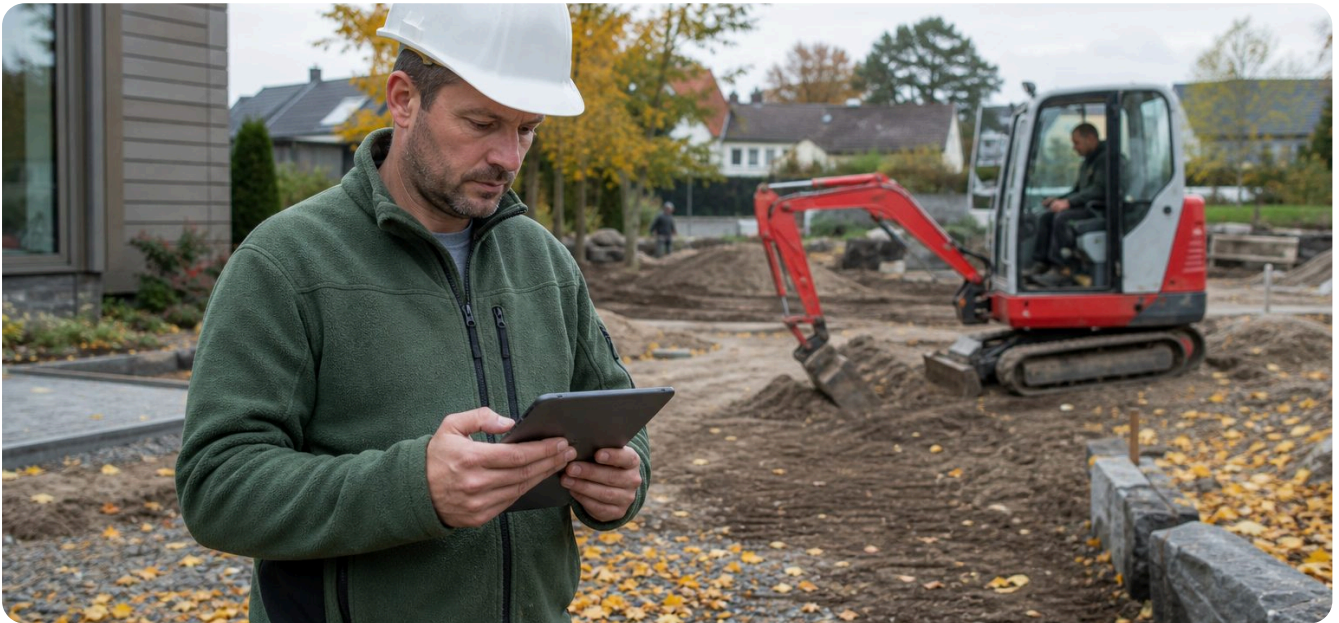
Oktober auf der Baustelle: Die Saison läuft aus, die Personalplanung für das nächste Jahr beginnt. · Symbolbild
