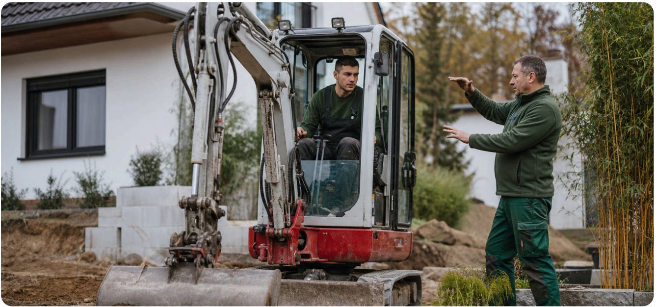
Qualifizierung, Unterweisung, Beauftragung: Drei Schritte, bevor jemand allein baggert. · Symbolbild
