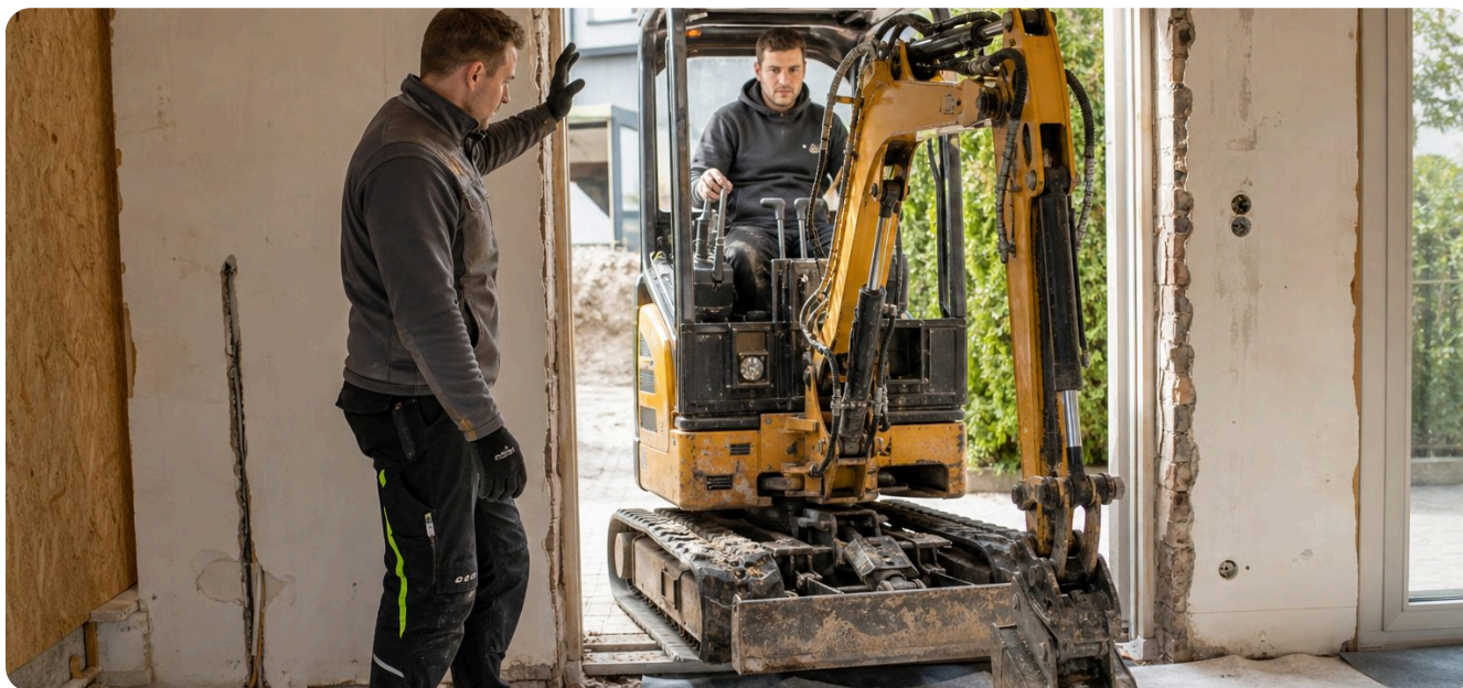
Durch die Terrassentür in den Keller: Der E10e ist für Baustellen gebaut, auf denen ein Diesel nicht laufen darf. · Symbolbild
